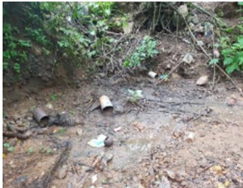
Figura 2. Tubo que vierte agua residual al río.
