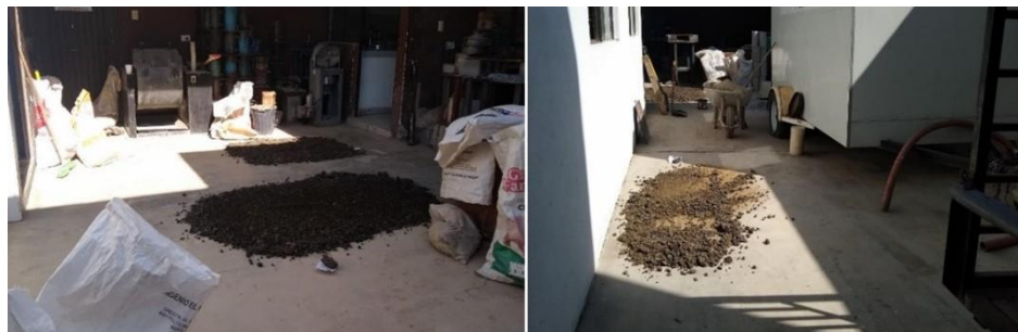
Figura 7. Área de secado invadida por material de desperdicio, herramienta de uso común y equipo especializado en desuso
